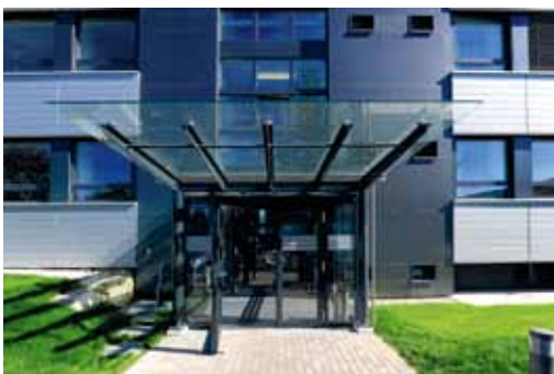
Entrée du personnel
